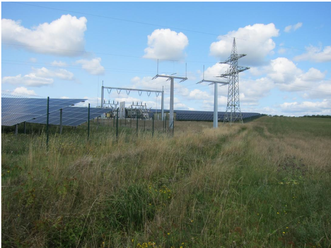
Abb. 2: Südwestrand Geltungsbereich mit angrenzender FF-PVA, neuem Umspannwerk und Entwässerungsgraben
