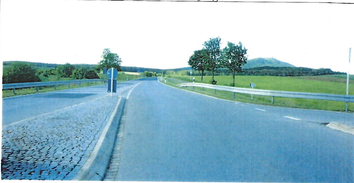
St 2283 _AXE 2 nördlicher Ast von Süden kommend Richtung Eicha
