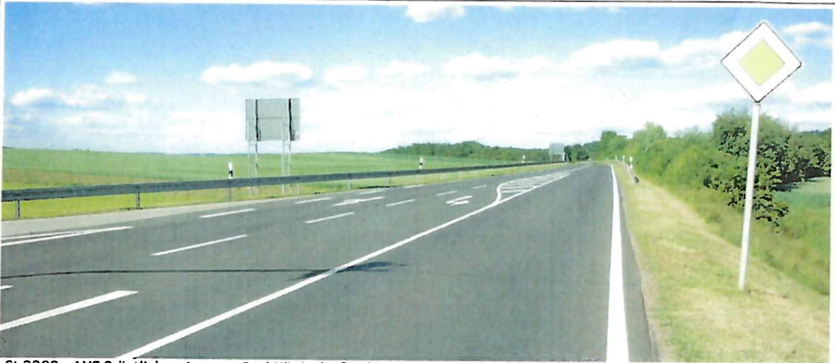
St 2282 AXE 3 östlicher Ast von Bad Königshofen kommend in Richtung Hildburghausen
