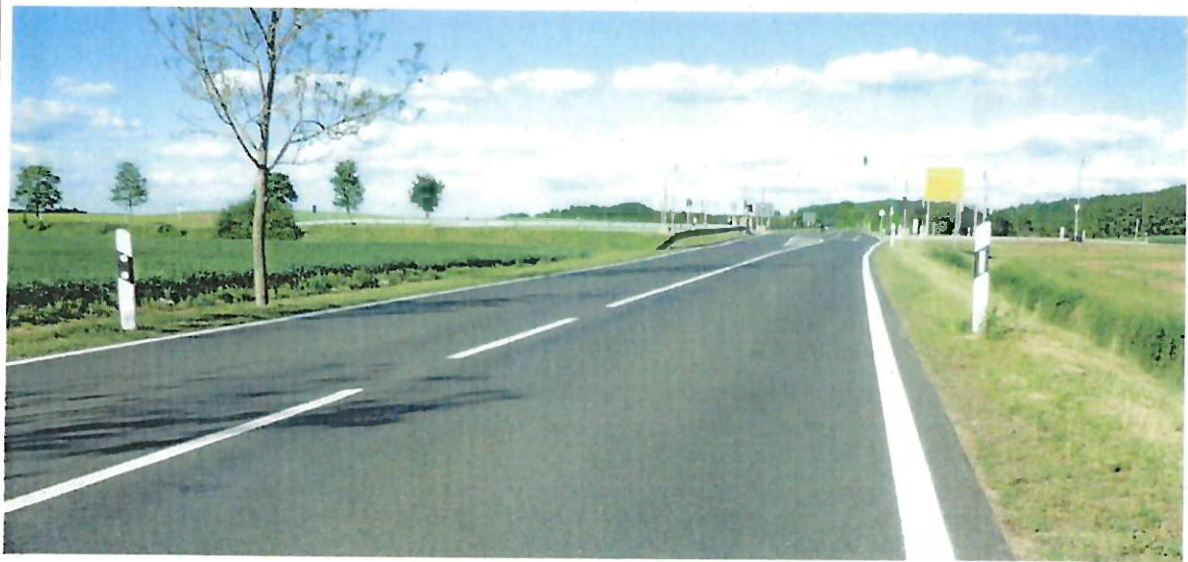
St 2282 AXE 1 westlicher Ast von Bad Königshofen kommend in Richtung Hildburghausen
